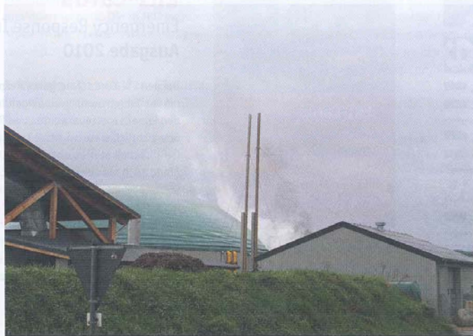
Für die ersten eintreffenden Kräfte der FF Meyn war bei der Anfahrt zur Einsatzstelle eine deutliche Rauchentwicklung über dem Gelände der Biogas-Anlage zu erkennen.
