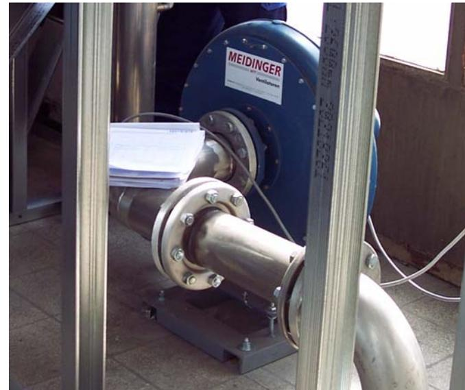
Fachmännisch verbaute Kompensatoren an einem Verdichter (links)
