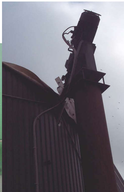
nicht gesichertes Rührwerk - > Hebelwirkung
