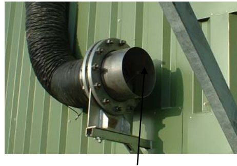
Regelmäßige Abluftmessungen wg. Gasdichtigkeit ! Zwischendach
