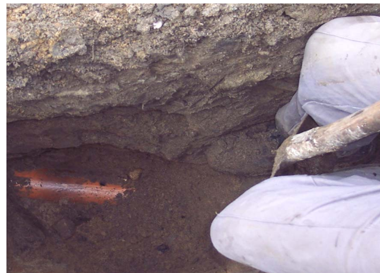
Handelsübliches KG-Rohr als Gasleitung
