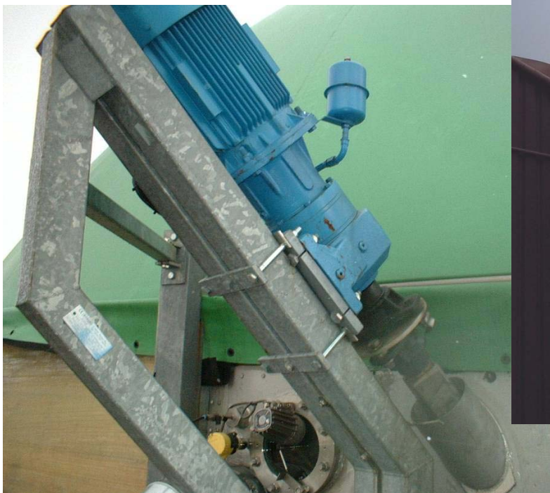
Gegen Schwingungen gesichertes Rührwerk
