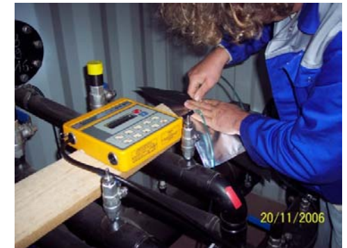
Abb.3 Messung in der Gassammelstation [DAS-IB GmbH, 2009]
