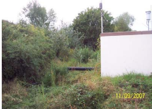
Abb. 6 Gassammelstation mit Wetterstation [DAS-IB GmbH, 2007]
