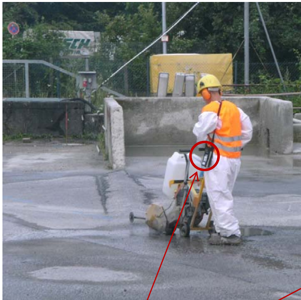
Abb.9 Schneidarbeiten an einer Betonoberfläche auf einer Altablagerung [DAS-IB GmbH, 2009]
