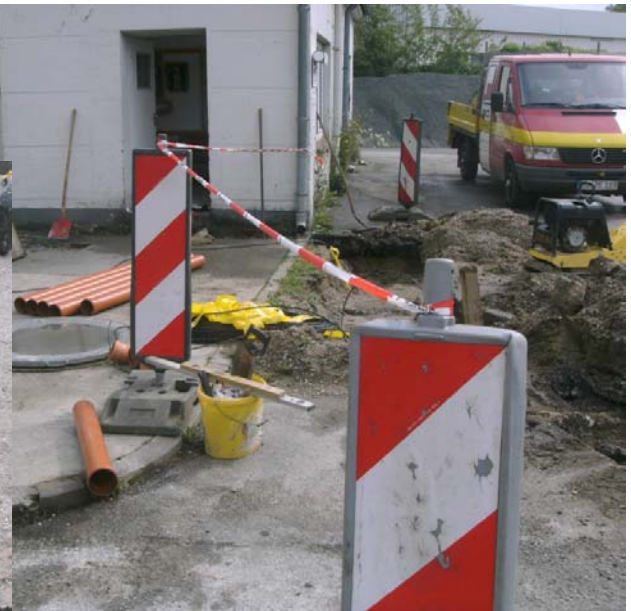
Abb.11 Baustelle auf einer Altablagerung in einem Gewerbegebiet [DAS-IB GmbH, 2009]
