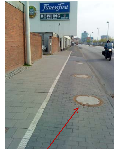
Abb. 14 Schächte für Revisionsöffnungen Absaugung
