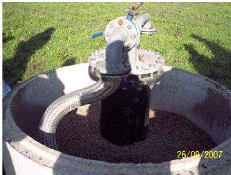
Abb.5 Brunnenkopf mit schräg eingebauter Klappe [DAS-IB GmbH, 2007]
