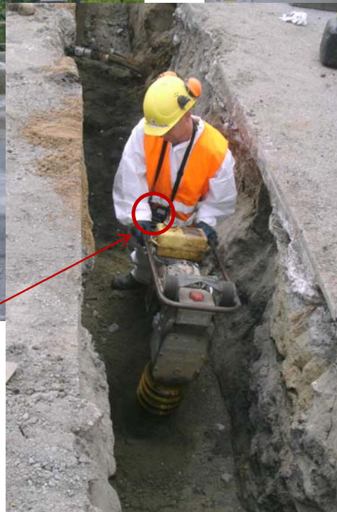
Abb.10 Verdichtungsarbeiten im Leitungsgraben auf bzw. In einer Altablagerung [DAS-IB GmbH, 2009]
