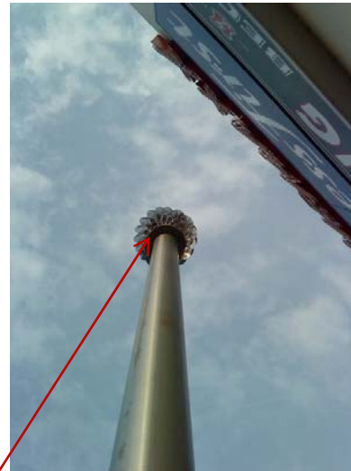
Abb. 13 Entlüfter auf einer auf einer Altablagerung [DAS-IB GmbH, 2010]
