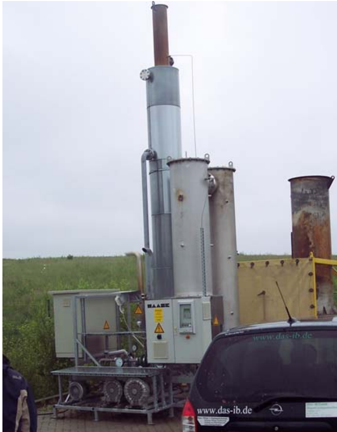
Photo 3: HAASE Schwachgasfackel, eigenes Photo
