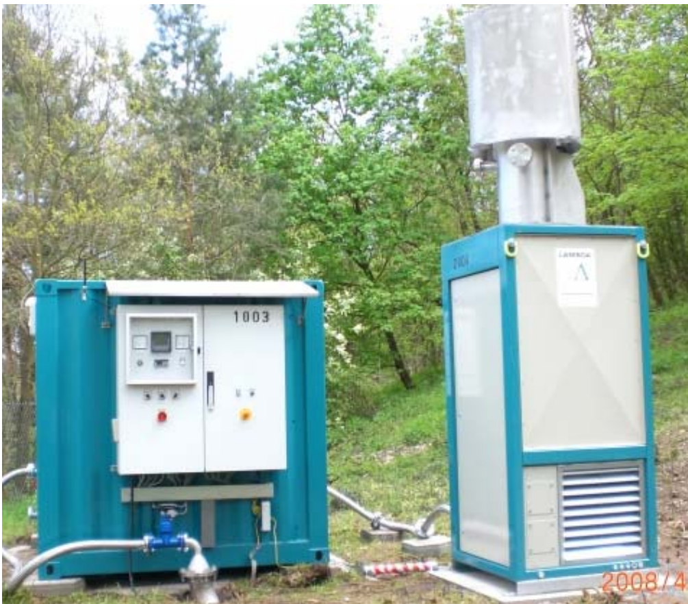
Photo 2: CHC – Anlage, Fabr. LAMBDA – Photo ZVA Erlangen
