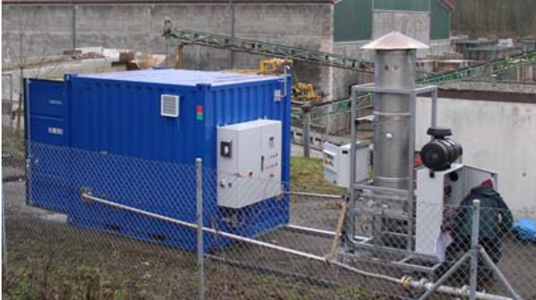
Photo 1: Schwachgasfackel Roediger BioEnergie – Werksphoto
