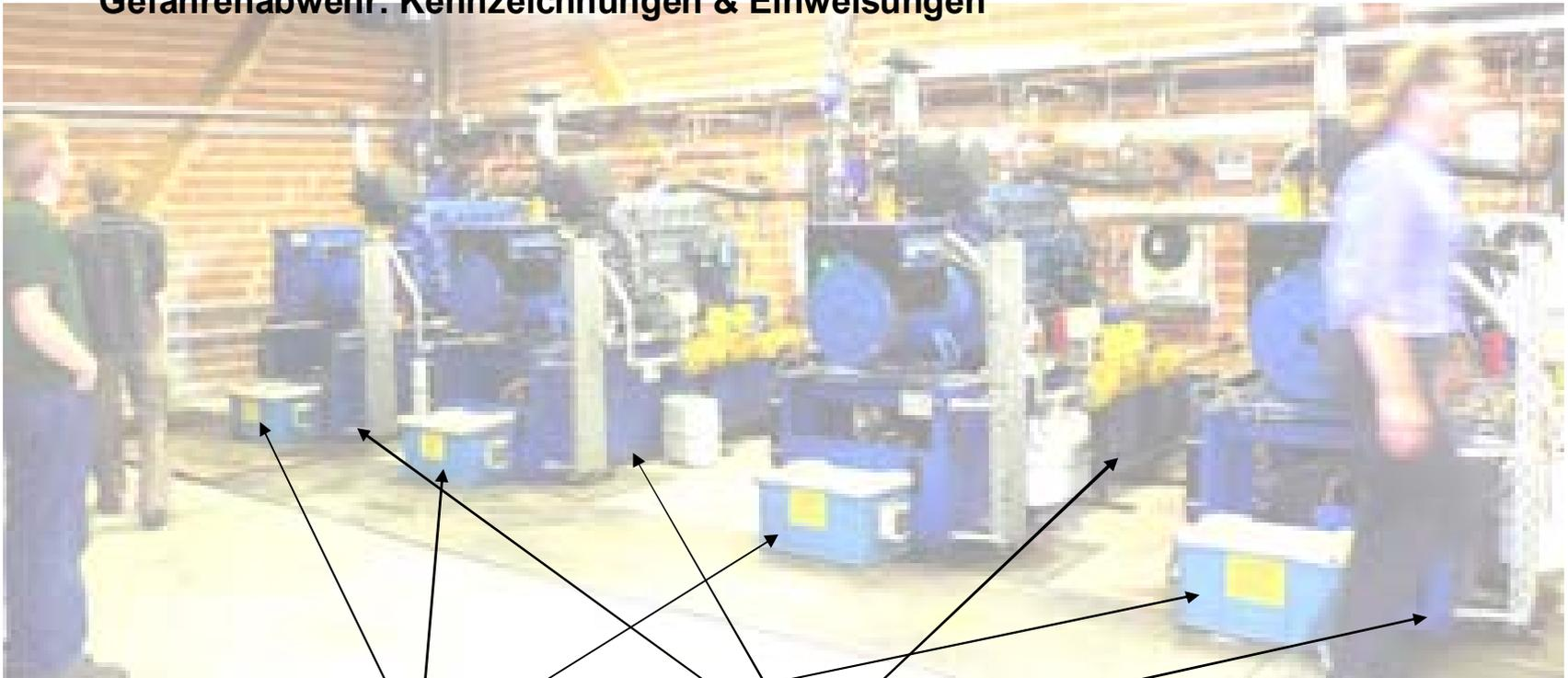
**BHKW mit Säurebatterien und Ölauffangwannen unter den Motoren
