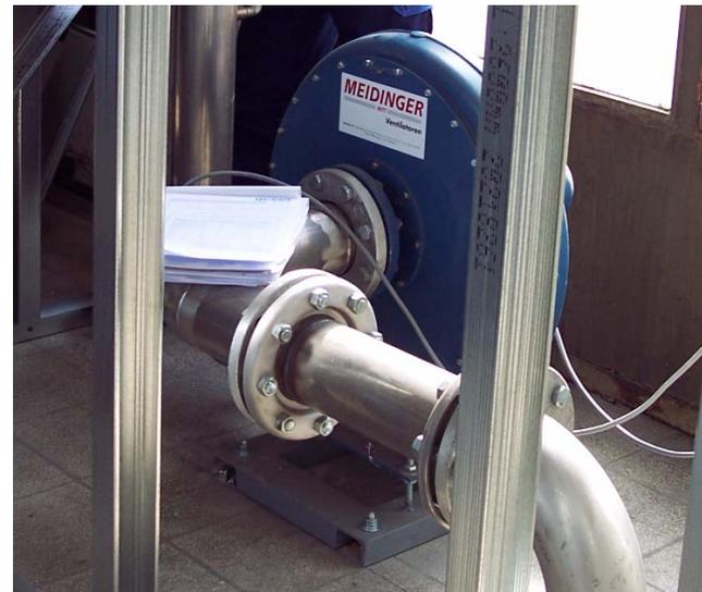
Fachmännisch verbaute Kompensatoren an einem Verdichter (links)
