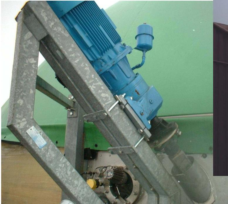
Gegen Schwingungen gesichertes Rührwerk
