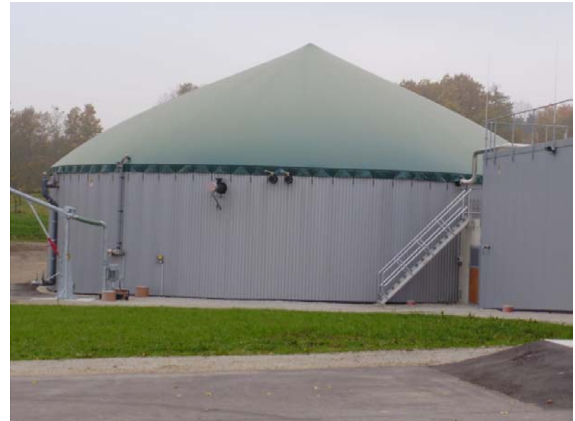
Foto rechts: Ansicht Gärproduktlager
