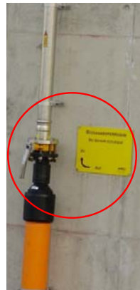
Foto oben: Zentraler Gasabsperrrahn außerhalb des BHKW- Aufstellraumes
