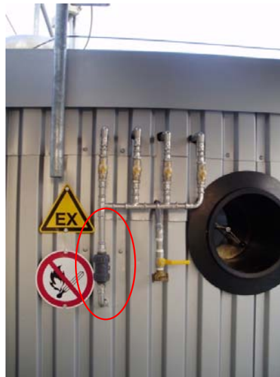
Foto oben: Dosierlanzen zur Entschwefelungslufteindüsung mit Rückschlagventil. Rechts: Sichtfenster
