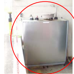
Foto oben: Altöllage außerhalb des BHKW- Aufstellraumes
