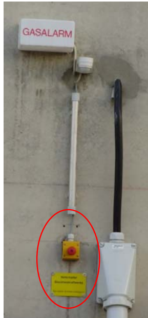
Foto oben: NOT-AUS-Schalter außen am BHKW- Aufstellraum
