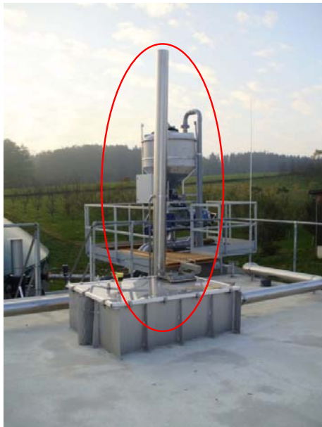
Foto oben: Überdrucksicherung mit Ausblasrohrleitung auf dem Dach des Fermenters
