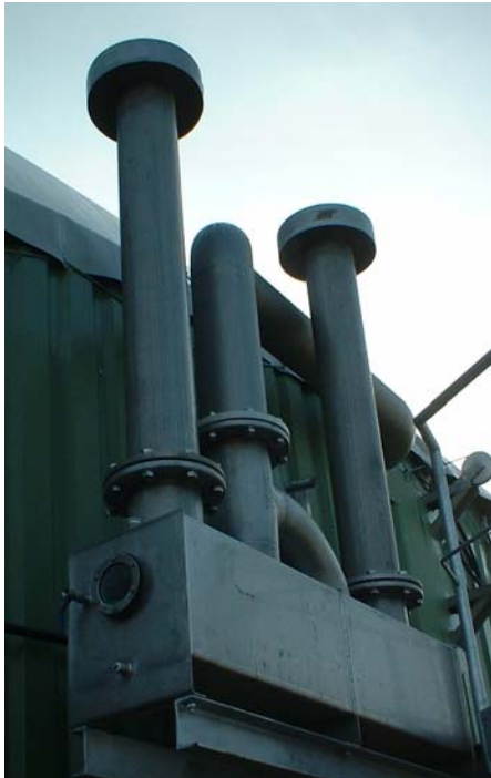
Überdruck-/Unterdrucksicherung am Fermenter
