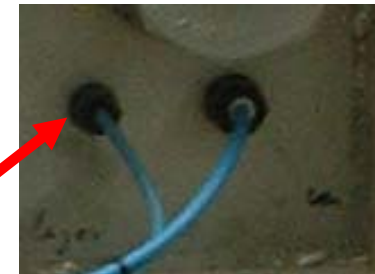
Durchführungen durch die Fermenterwand
